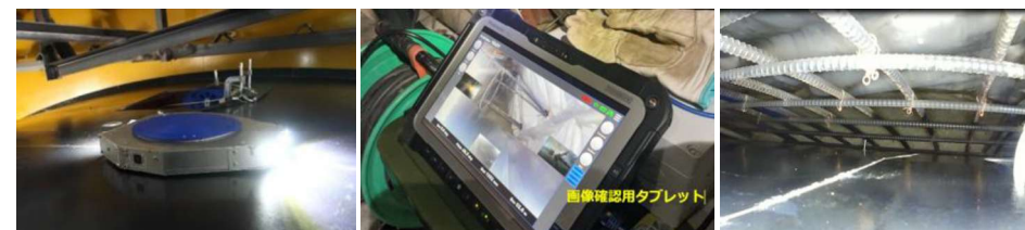
「トンネルやもりん」検査状況
